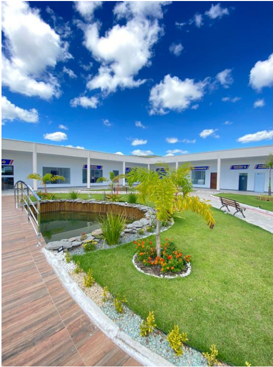
Figura 3- 2ª etapa da construção do Centro Administrativo de Milagres.
