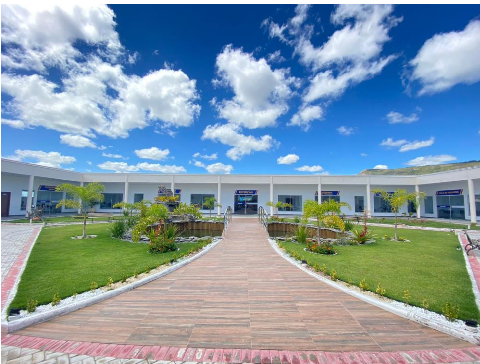
Figura 2- 2ª etapa da construção do Centro Administrativo de Milagres.
