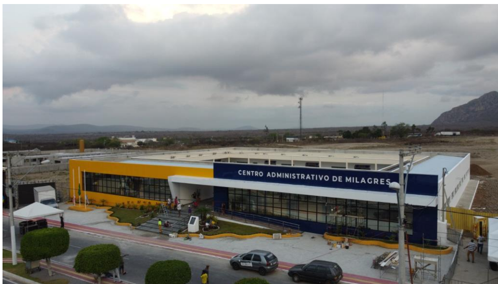
Figura 1- 2ª etapa da construção do Centro Administrativo de Milagres
