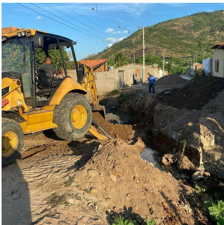
Figura 2- Pavimentação e drenagem
