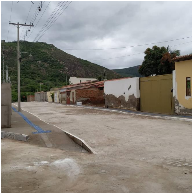
Figura 3- Pavimentação e drenagem
