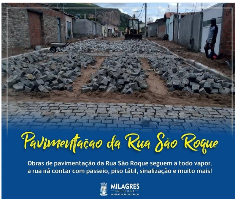
Figura 1- Pavimentação e drenagem
