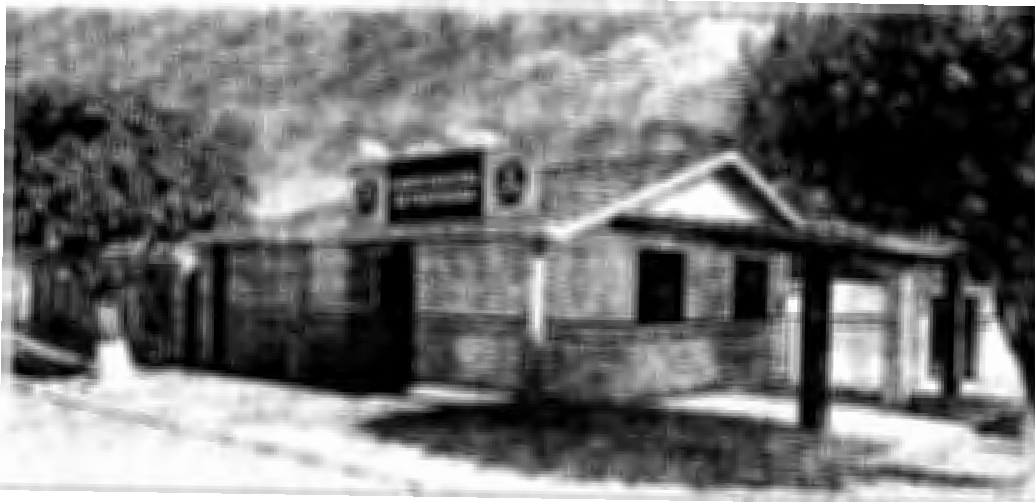
Continuidade da Obra de abastecimento de água na região rural
