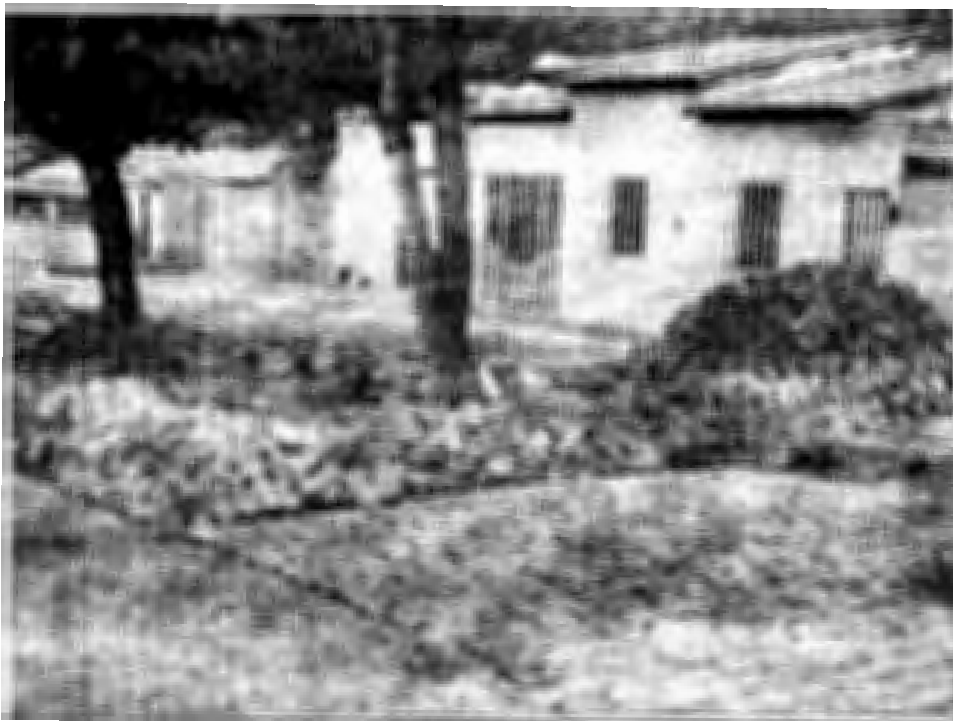
Continuidade das obras na Rua do Chafariz
