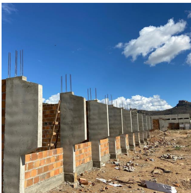
Figura 2- Construção de escola com 12 salas de aula.
