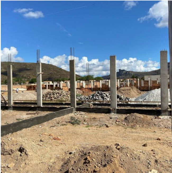
Figura 3- Construção de escola com 12 salas de aula.
