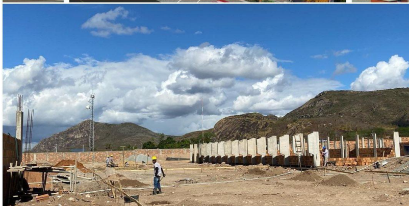
Figura 1- Construção de escola com 12 salas de aula.
