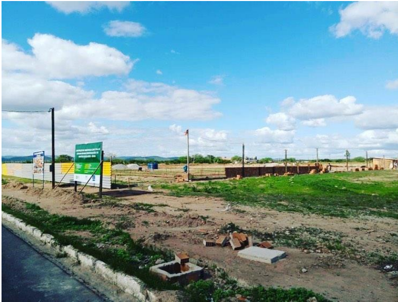
Figura 4- Construção de escola com 12 salas de aula.
