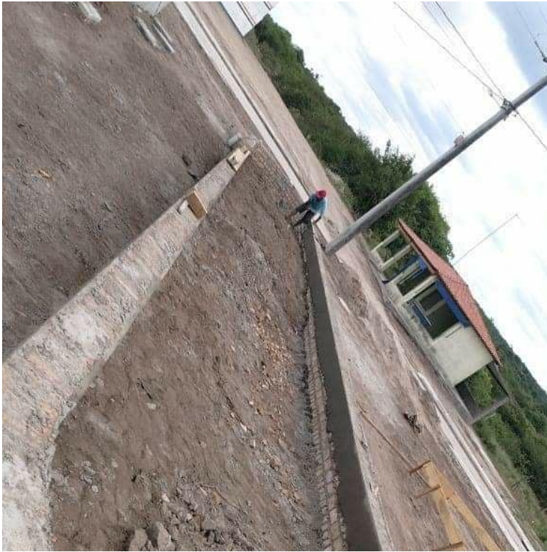
Figura 3– Construção com urbanização de praça na Gameleira
