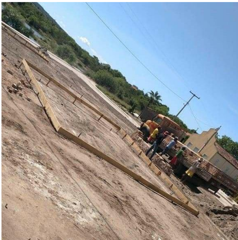
Figura 2 – Construção com urbanização de praça na Gameleira
