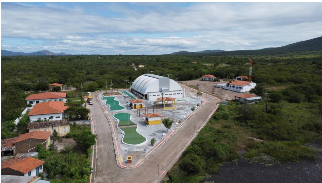
Figura 1 – Construção com urbanização de praça na Gameleira..
