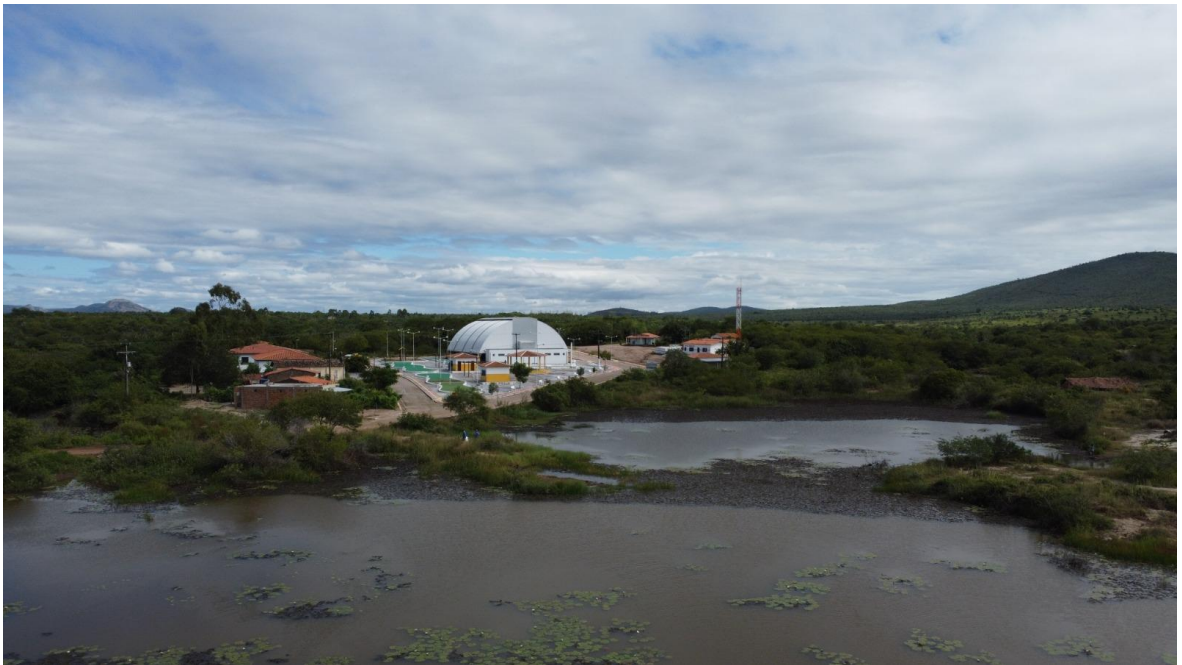
Figura 4– Construção com urbanização de praça na Gameleira
