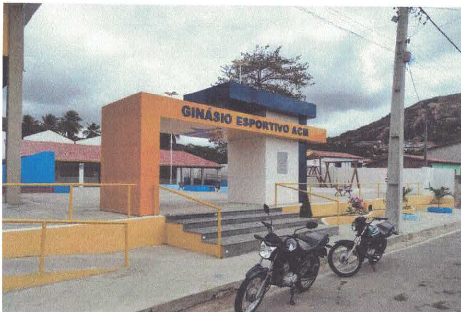
Figura 1 – Revestimento metálico do portal
