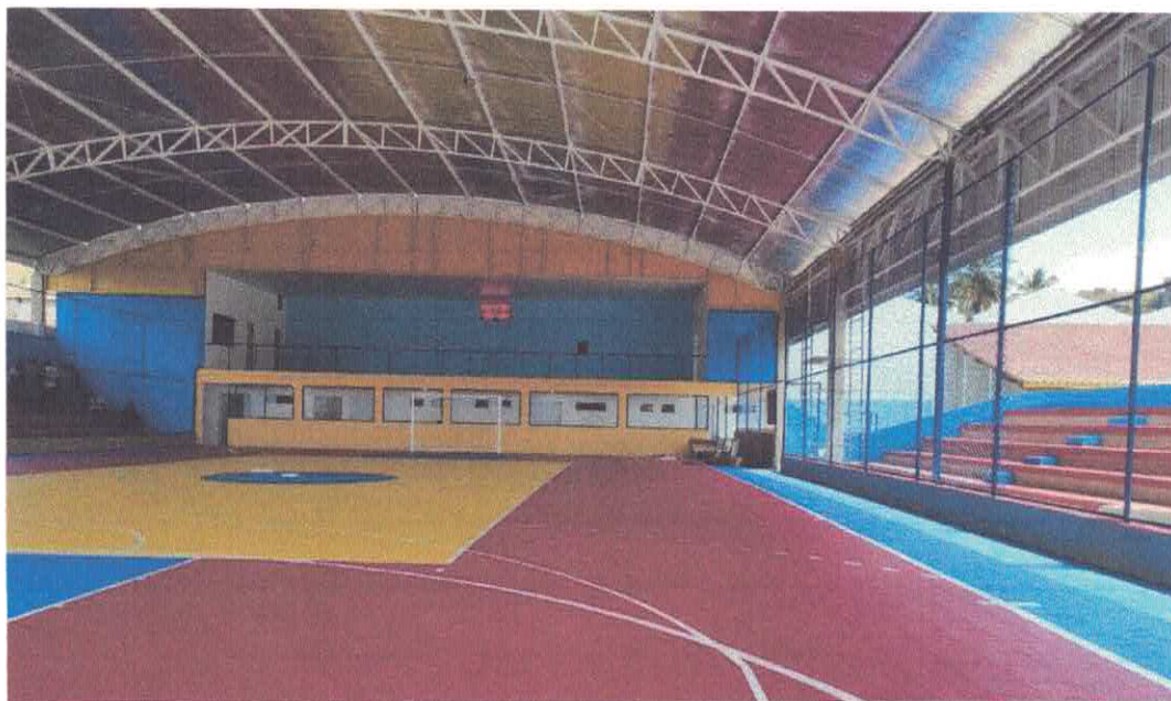
Figura 1 – Instalação do guarda-corpo
