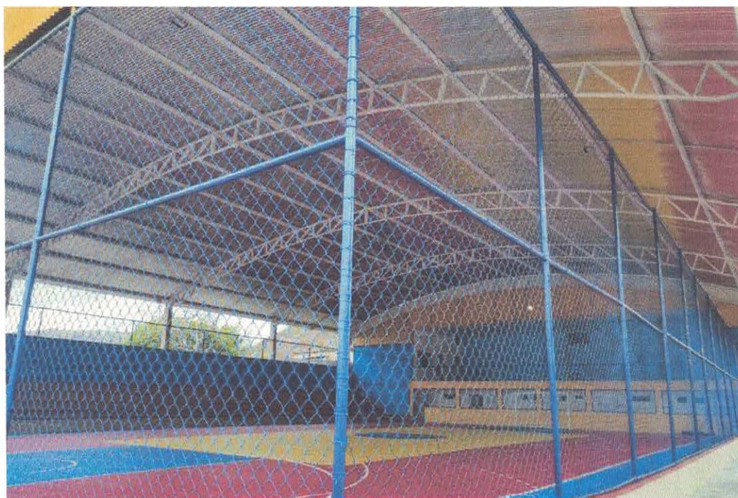
Figura 2 – Pintura em superfícies metálicas
