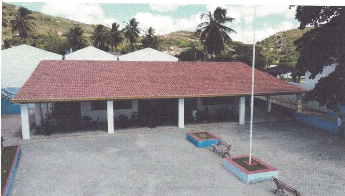
Figura 1 – Execução em piso intertravado
