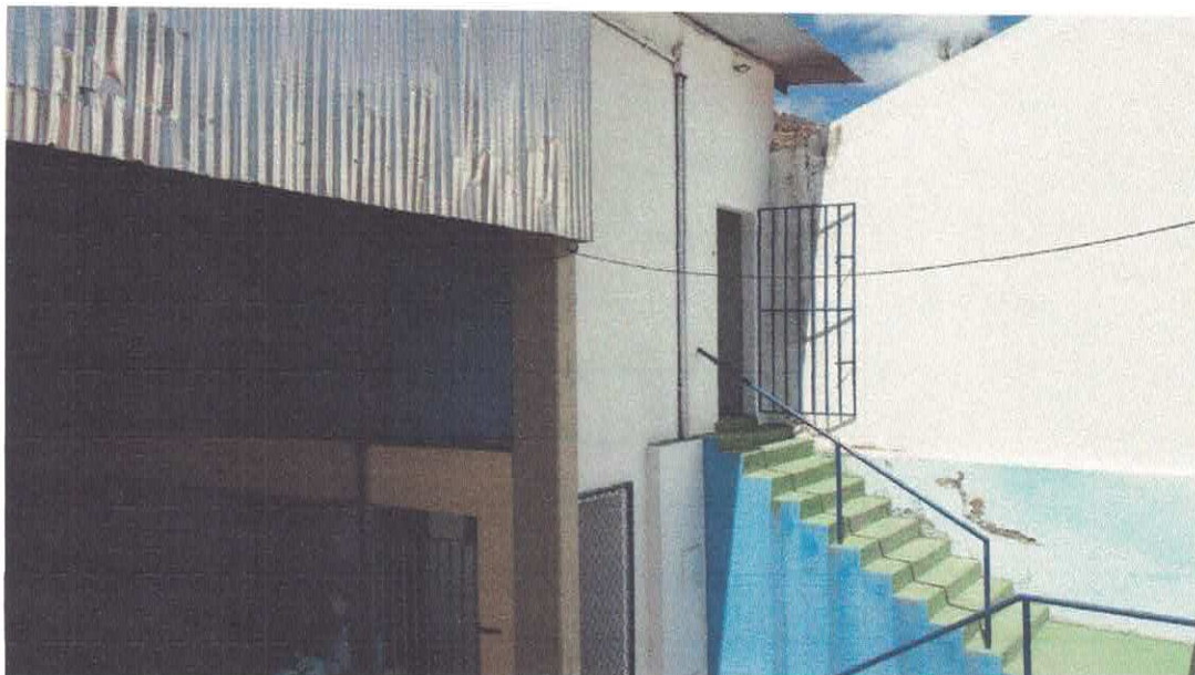
Figura 1 – Pintura em superfícies metálicas
