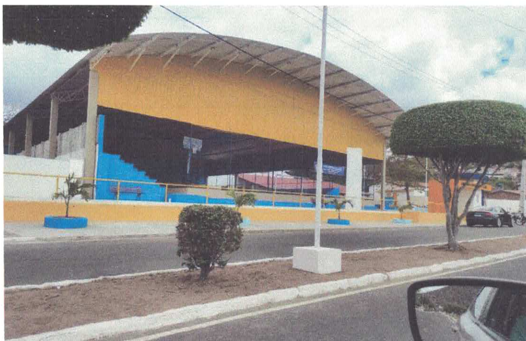
Figura 2 – Revestimento metálico do portal
