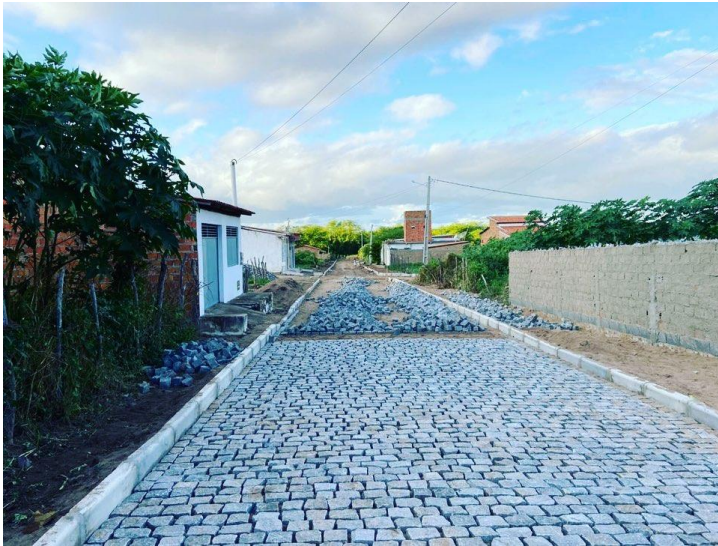
Figura 3- Pavimentação em palalelepipedos em diversas ruas.
