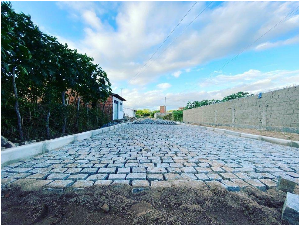
Figura 4- Pavimentação em palalelepipedos em diversas ruas.
