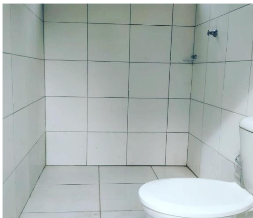
Figura 2 – Construção de 43 und. De melhorias sanitarias em Milagres/BA.
