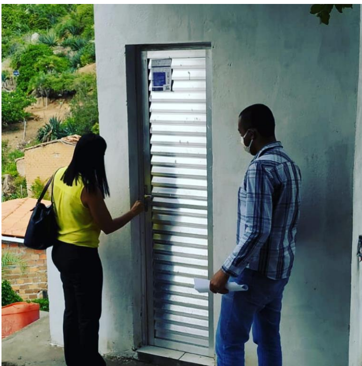
Figura 1 – Construção de 43 und. De melhorias sanitarias em Milagres/BA.
