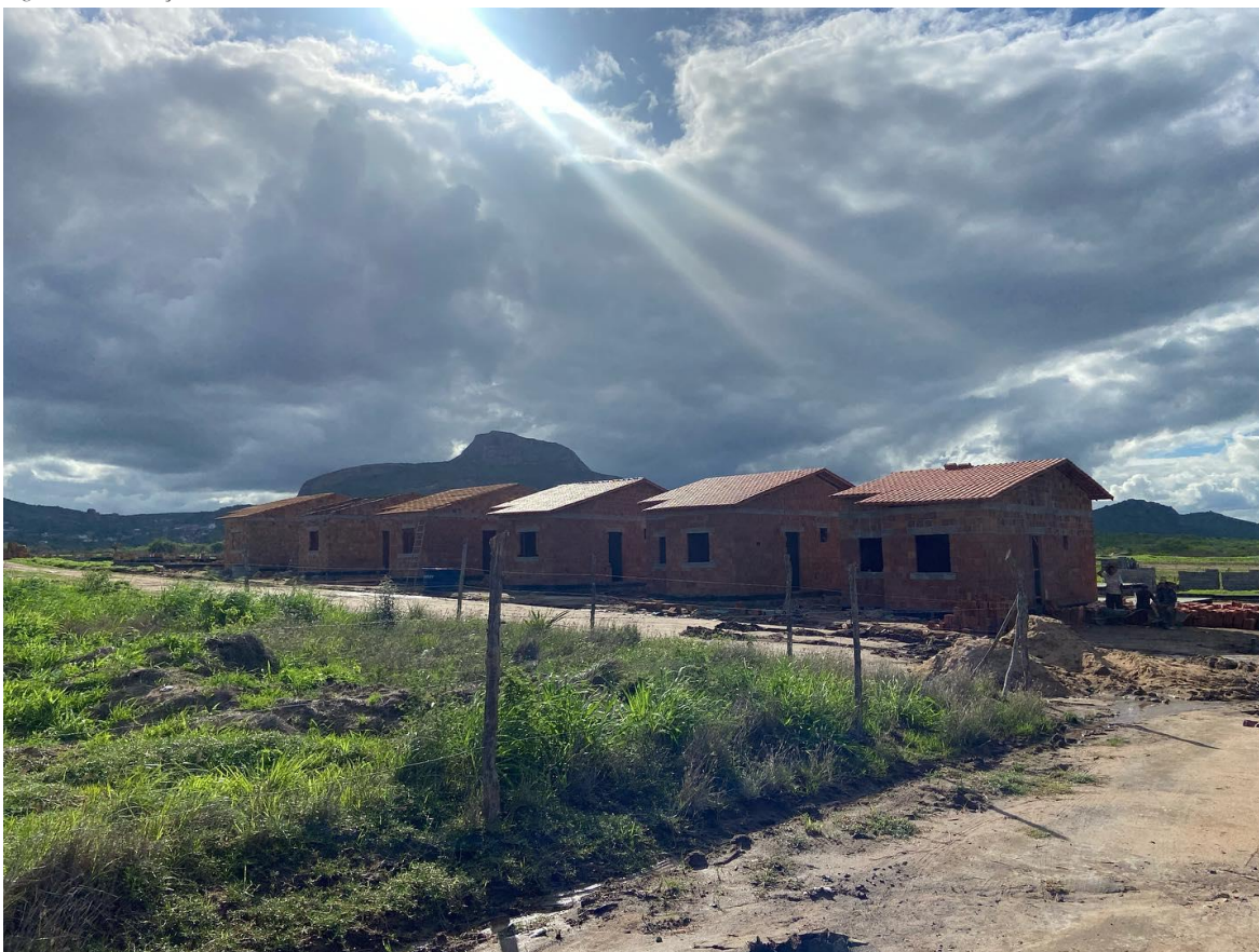
Figura 2- Construção de unidades habitacionais
