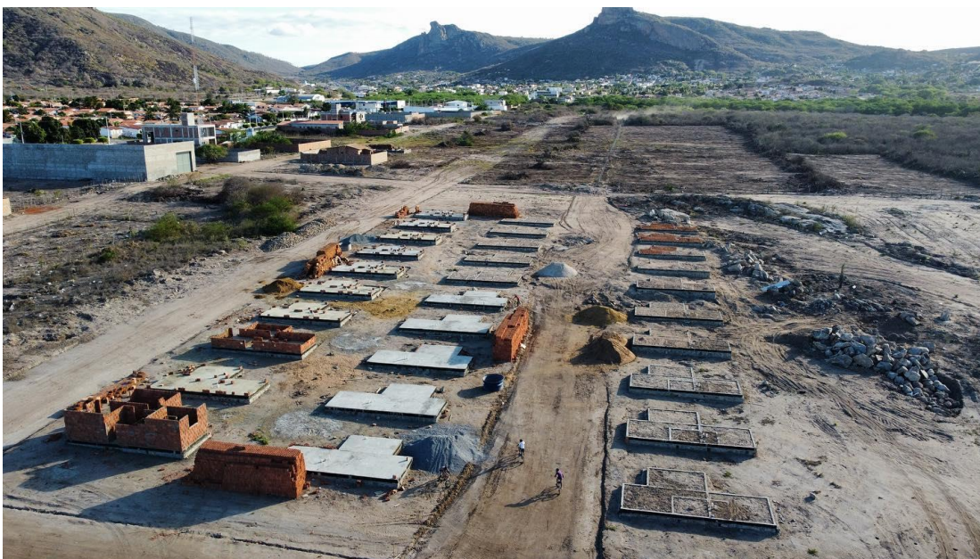
Figura 1- Construção de unidades habitacionais
