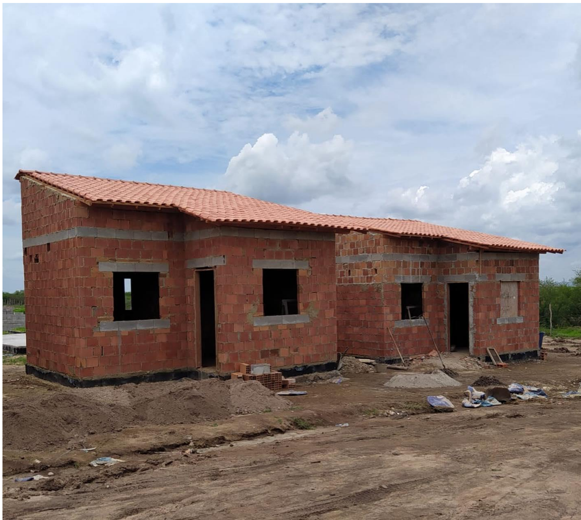
Figura 3- Construção de unidades habitacionais
