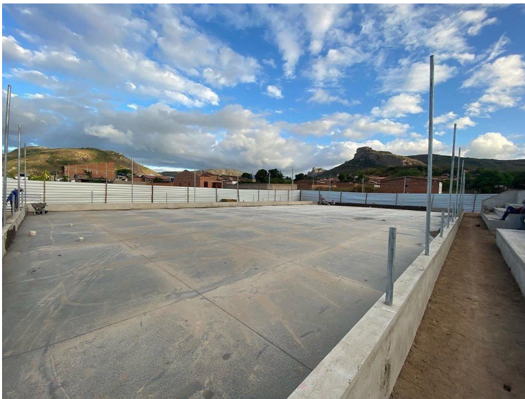
Figura 1 Construção de quadra poliesportiva com arquibancada
