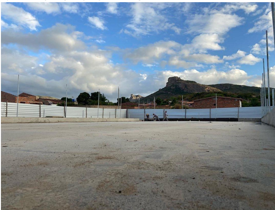
Figura 2 - Construção de quadra poliesportiva com arquibancada
