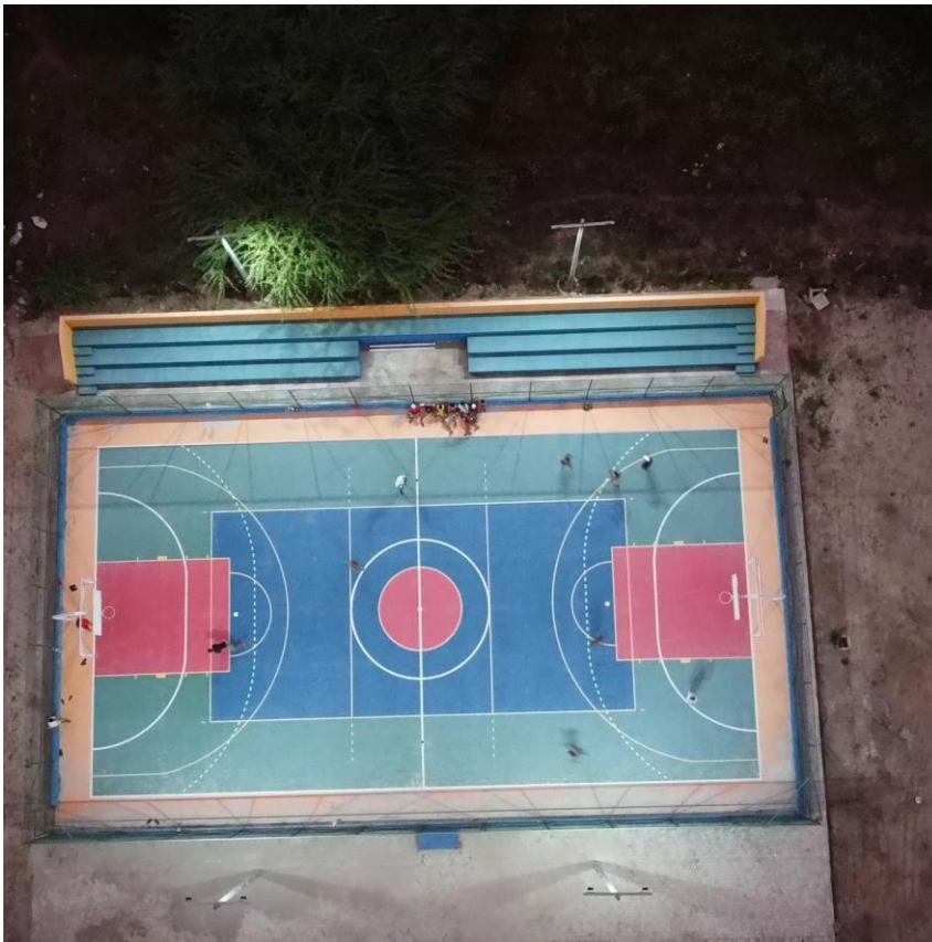
Figura 4 - Construção de quadra poliesportiva com arquibancada
