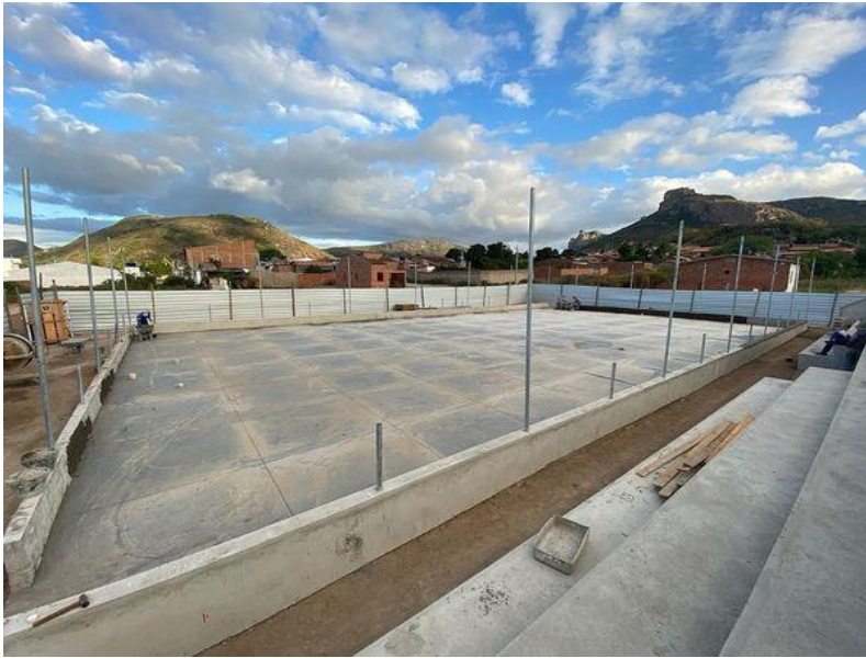
Figura 3 - Construção de quadra poliesportiva com arquibancada
