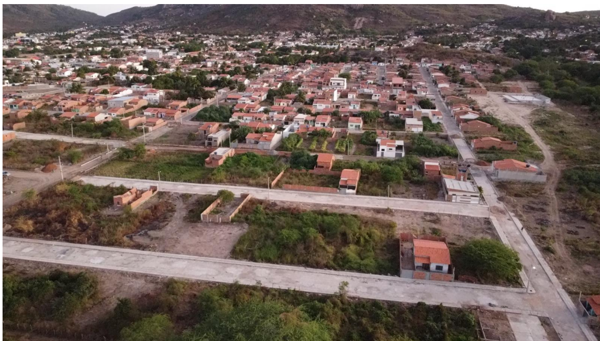
Figura 2 – Pavimentação e Drenagem da Rua Sinval Ribeiro Souza Neto
