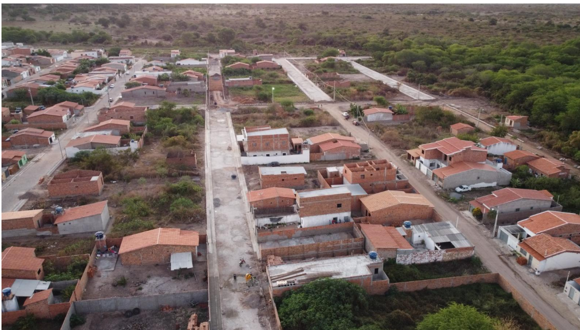
Figura 1 – Pavimentação e Drenagem da Rua Sinval Ribeiro Souza Neto.
