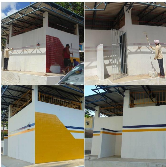
Figura 1- Reforma de prédios públicos e alugados.
