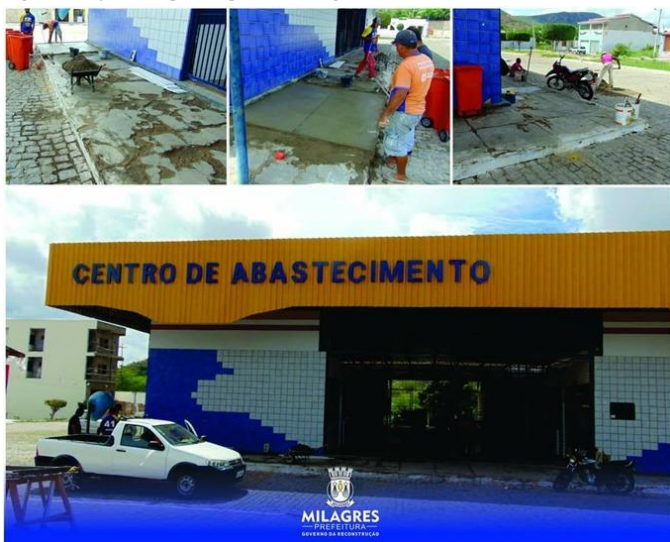
Figura 2- Reforma de prédios públicos e alugados.
