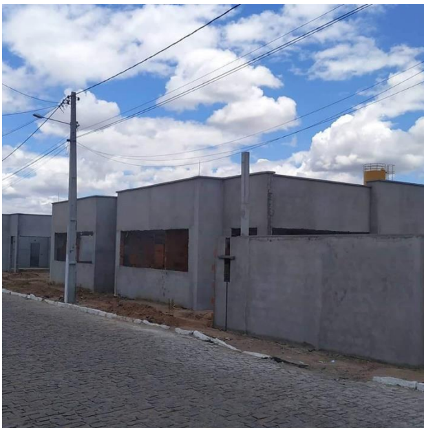
Figura 2- Construção de creche na sede do Município
