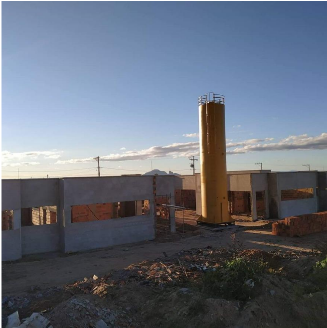
Figura 3- Construção de creche na sede do Município
