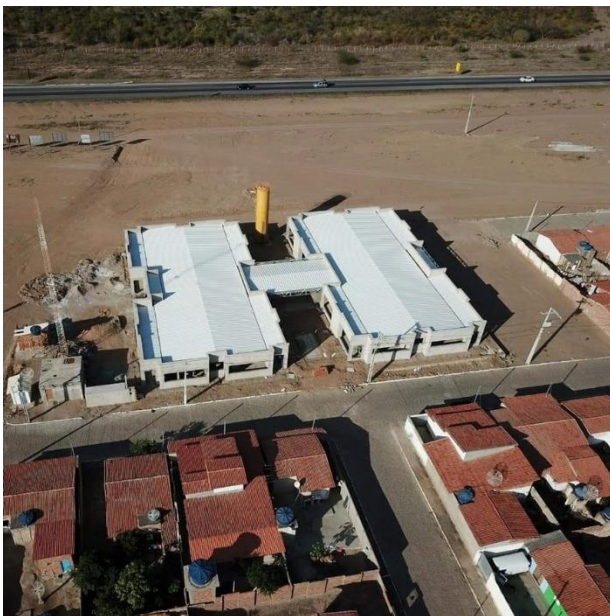
Figura 1- Construção de creche na sede do Município.
