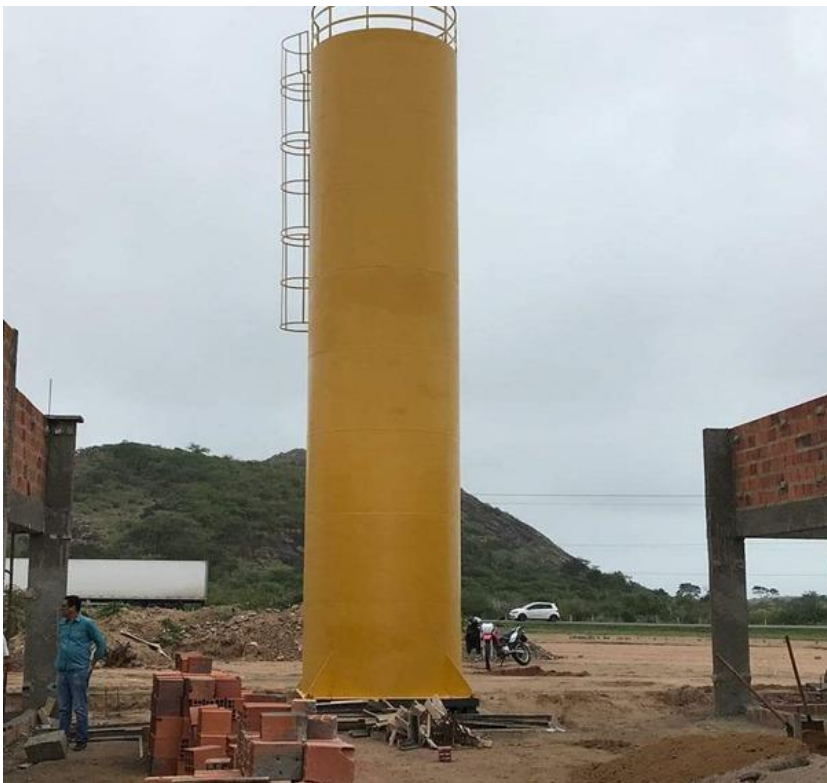
Figura 4- Construção de creche na sede do Município
