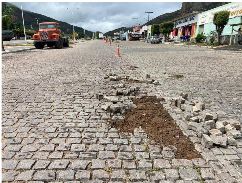
Figura 3-- Manutenção de pavimentação e drenagem
