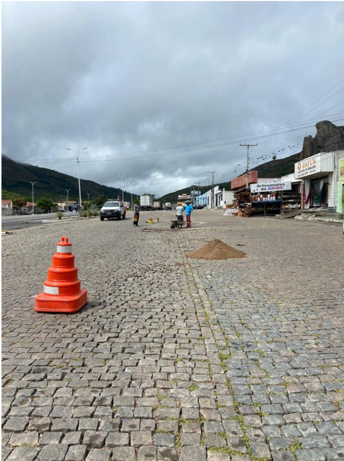
Figura 2-- Manutenção de pavimentação e drenagem
