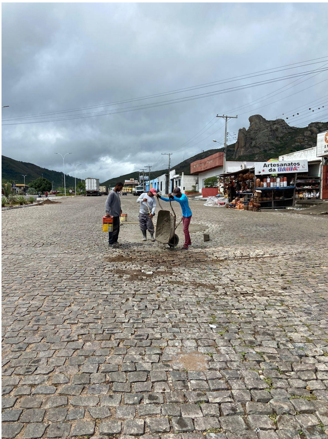
Figura 1-- Manutenção de pavimentação e drenagem
