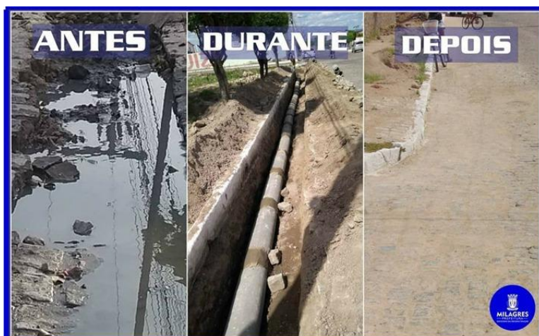
Figura 2 – Recuperação e drenagem de pavimentação.
