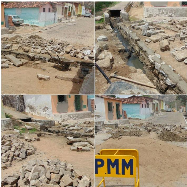
Figura 1 – Recuperação e drenagem de pavimentação
