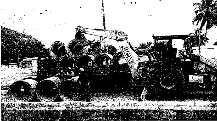
Início da Obra de extensão da rede pluvial na Rua do Chafariz
