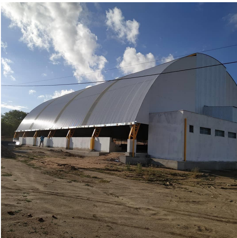
Figura 1 – Construção da Quadra Poliesportiva Coberta..
