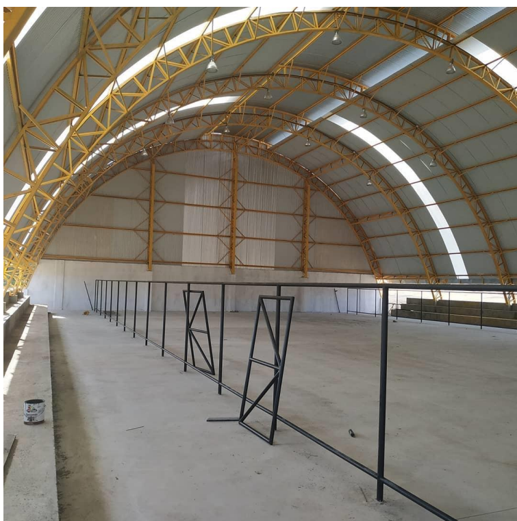
Figura 2 – Construção da Quadra Poliesportiva Coberta..
