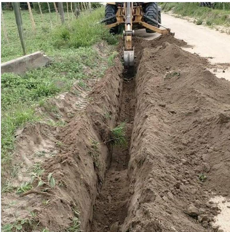
Figura 2- 3ª etapa Sistema Integrado de abastecimento de água
