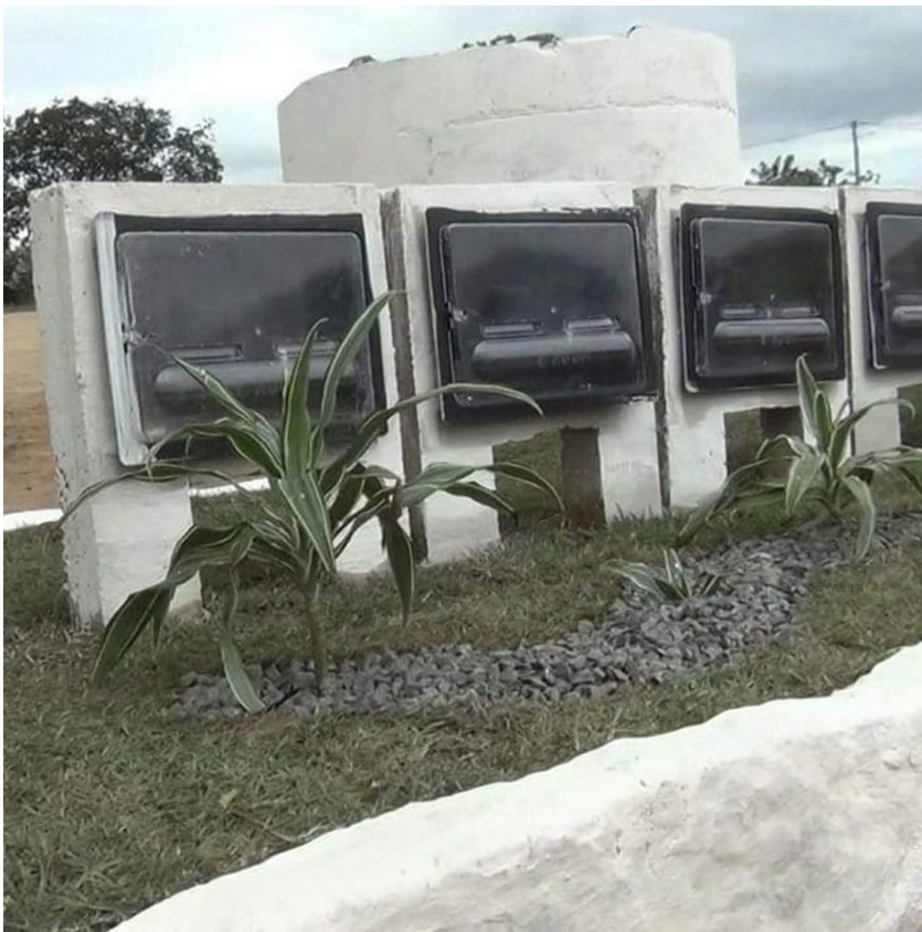
Figura 4- 3ª etapa Sistema Integrado de abastecimento de água
