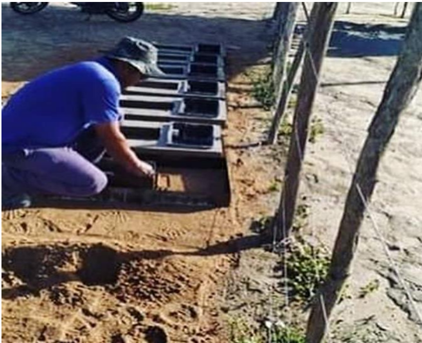
Figura 3- 3ª etapa Sistema Integrado de abastecimento de água
