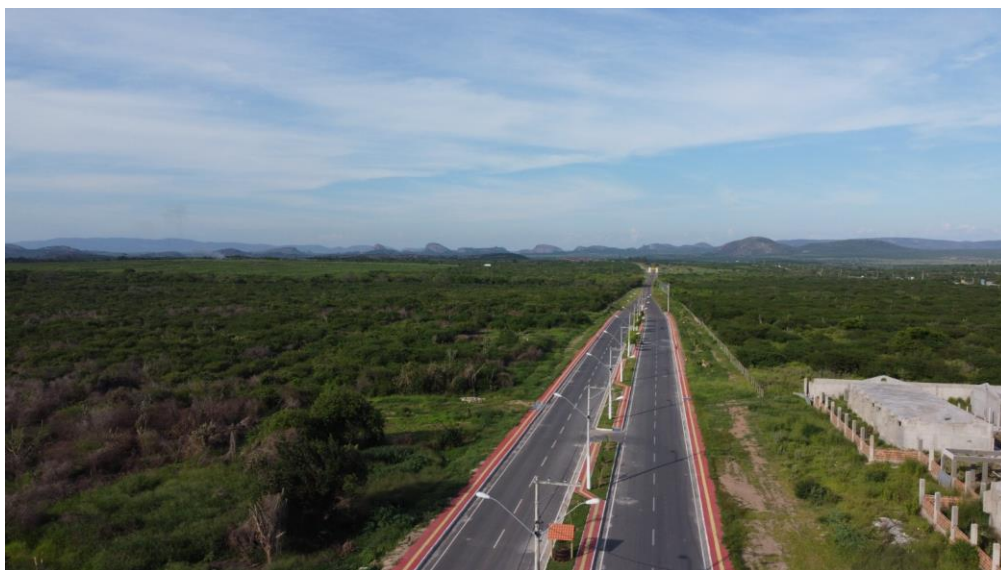
Figura 1- Recapeamento Asfáltico Av. Conrado Menezes
