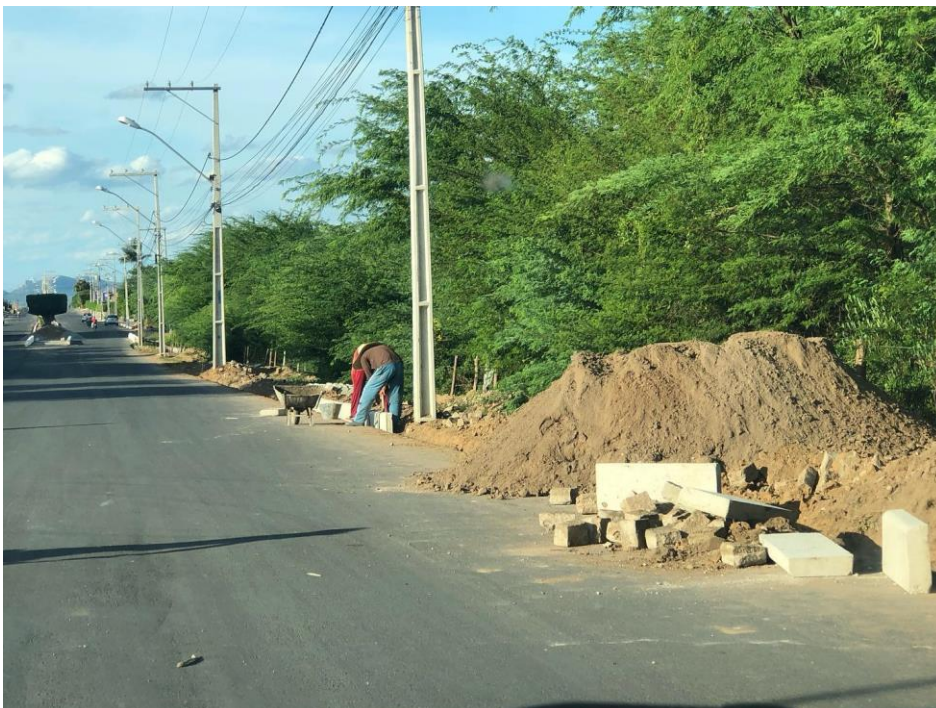
Figura 2- Recapeamento Asfáltico Av. Conrado Menezes
