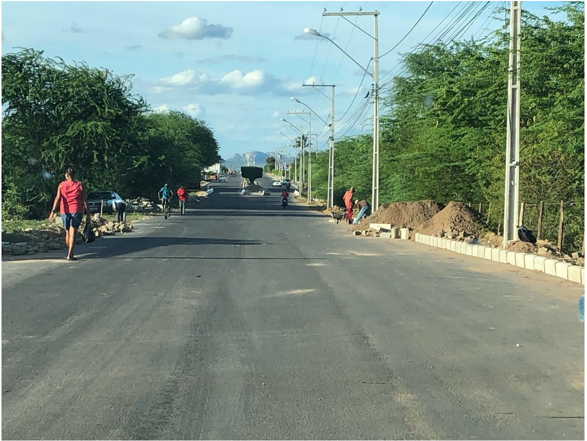
Figura 3- Recapeamento Asfáltico Av.Conrado Menezes
