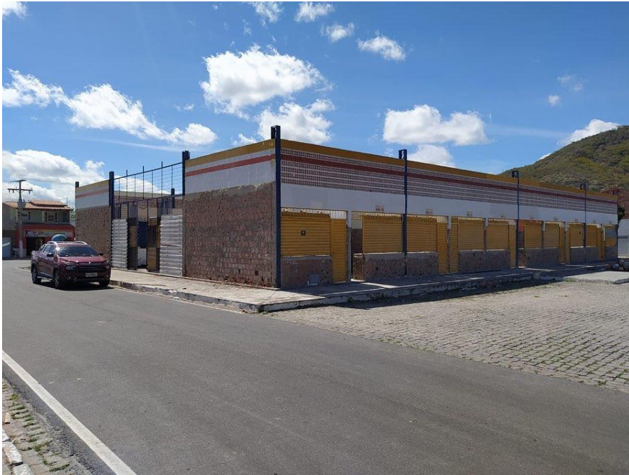
Figura 3- Reforma do Centro de Abastecimento.
