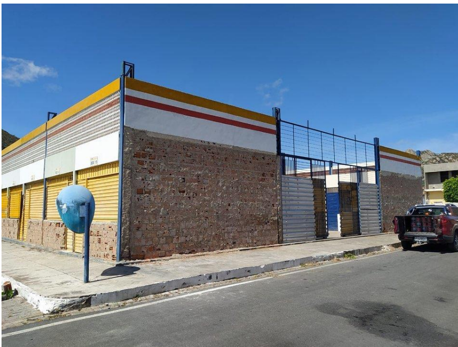
Figura 4 - Reforma do Centro de Abastecimento.
