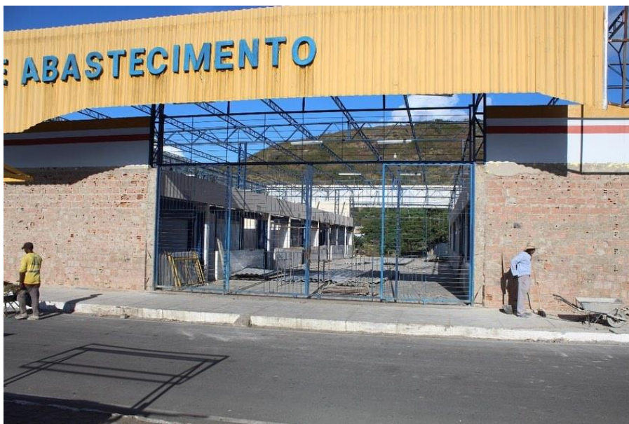
Figura 1- Reforma do Centro de Abastecimento.
