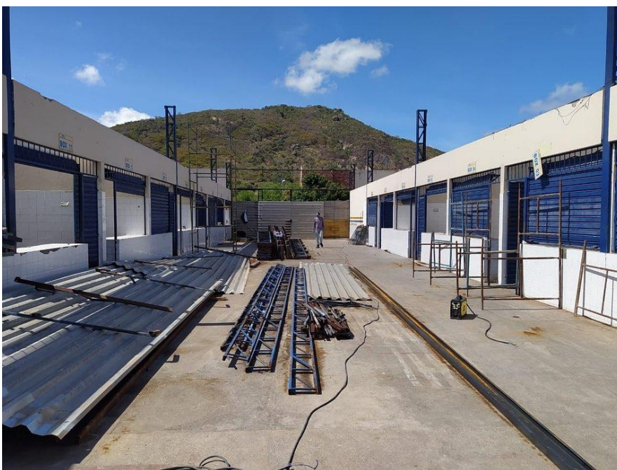
Figura 2- Reforma do Centro de Abastecimento
