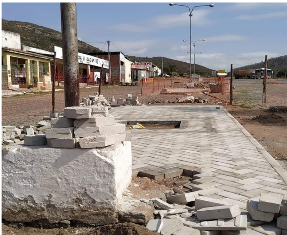
Figura 1- Requalificação da Avenida Lomanto Júnior.
