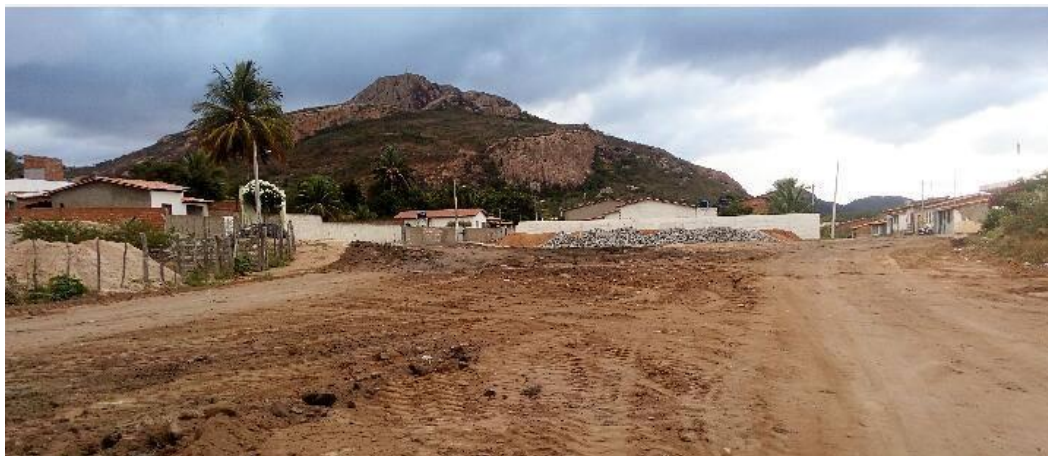
Figura 1 – Pavimentação da Rua Sinval Ribeiro Souza Neto.
