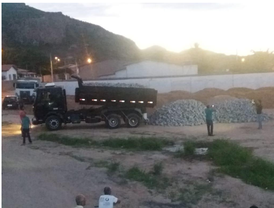
Figura 2 - Pavimentação da Rua Sinval Ribeiro Souza Neto
