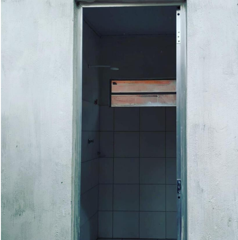
Figura 1 - Construção de 25 melhorias sanitárias
