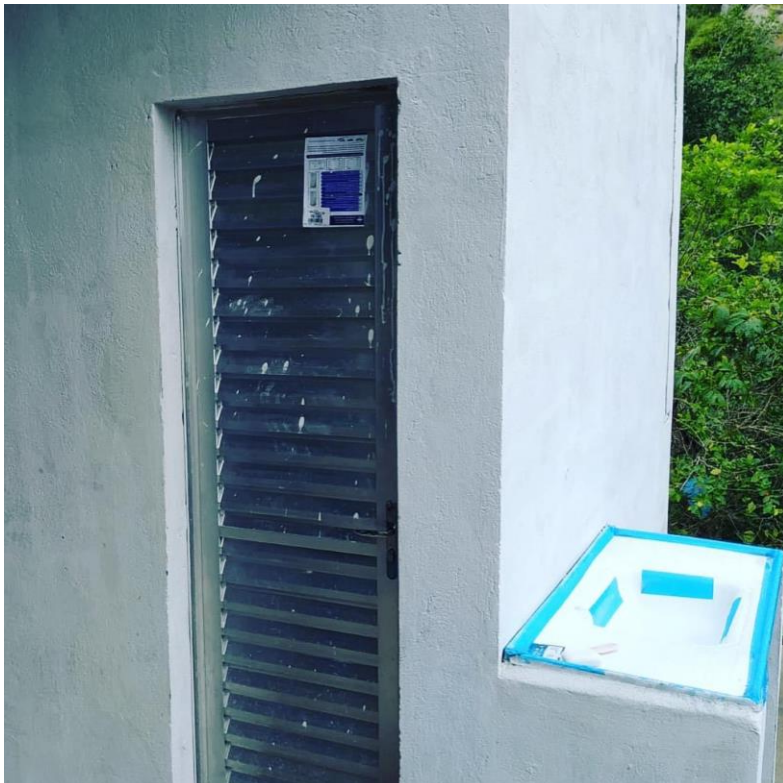
Figura 2 - Construção de 25 melhorias sanitárias
