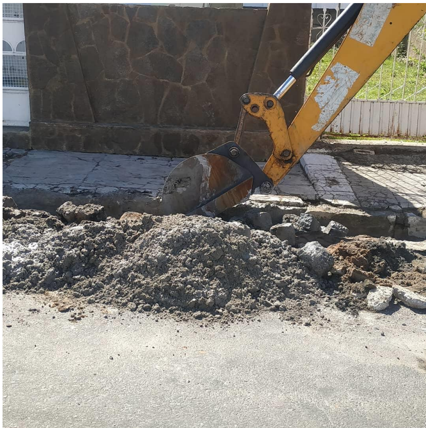
Figura 3 - Serviço de drenagem em diversas ruas..
