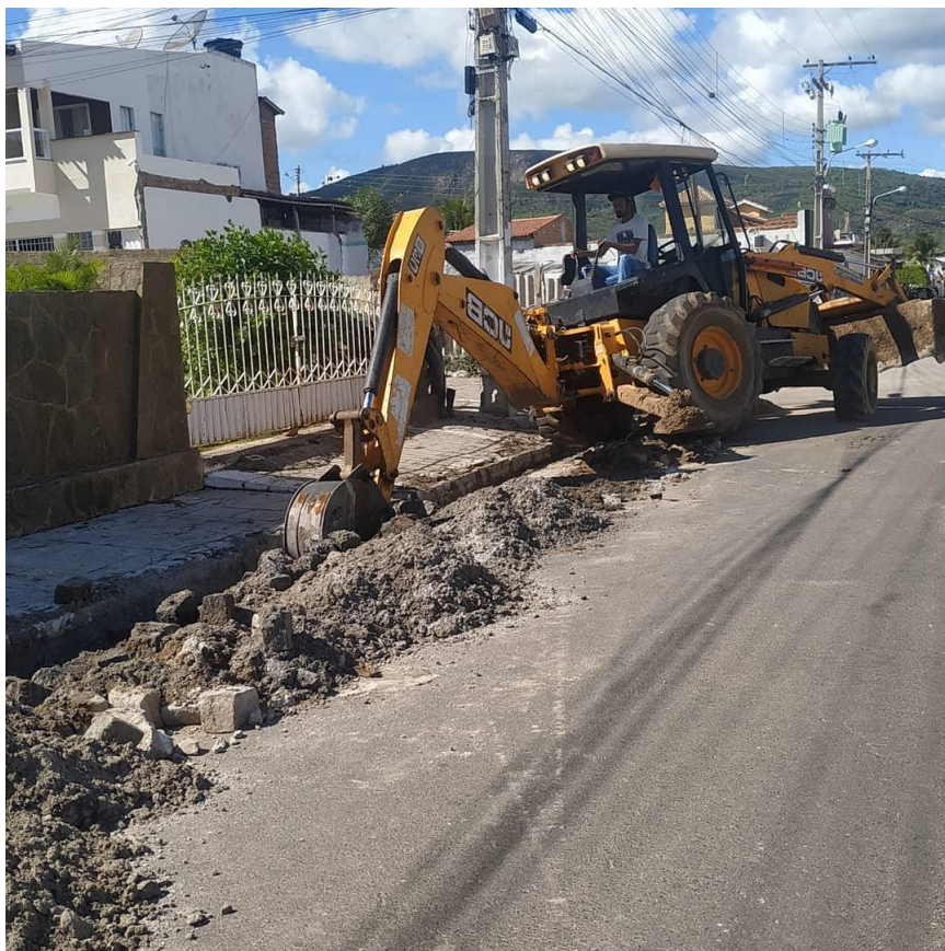
Figura 1 - Serviço de drenagem em diversas ruas..
