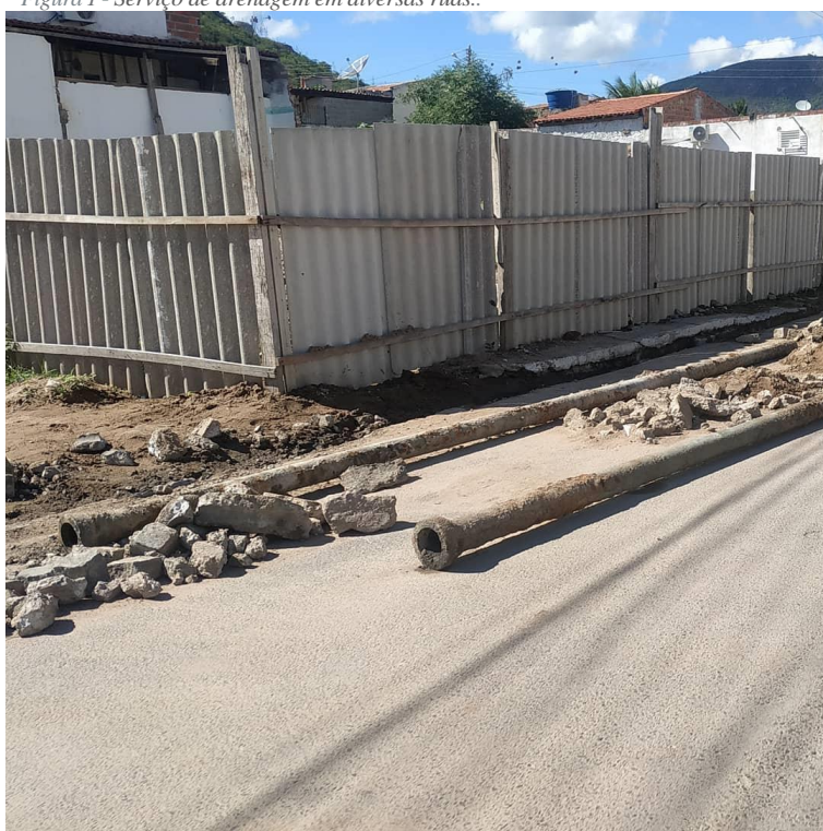
Figura 2 - Serviço de drenagem em diversas ruas
