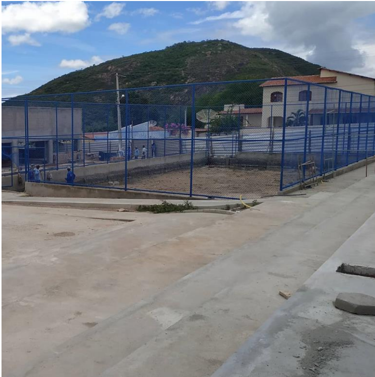
Figura 3 – Construção Praça da Juventude...
