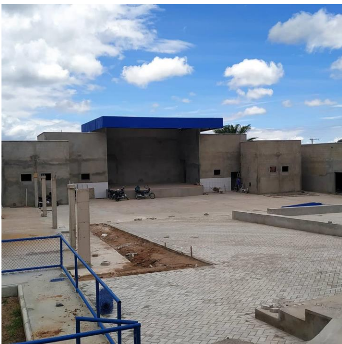
Figura 1 –Construção Praça da Juventude
