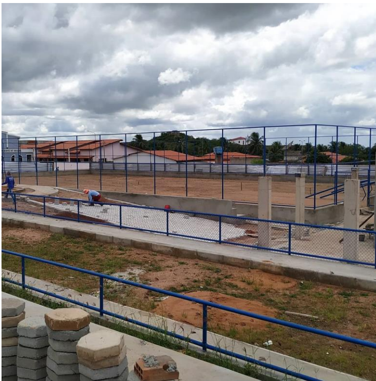
Figura 4 – Construção Praça da Juventude...
