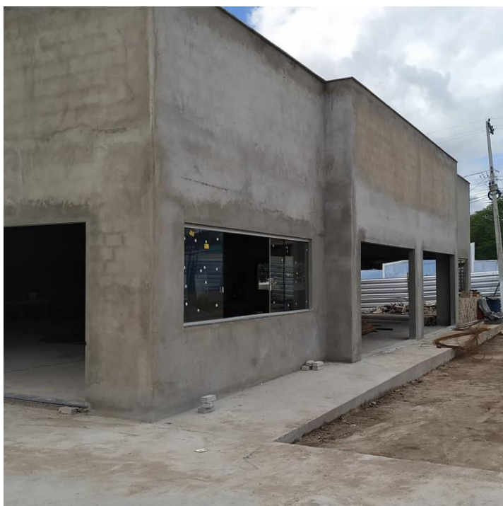
Figura 2 –Construção Praça da Juventude...
